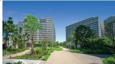
外観写真(2016年5月撮影)
