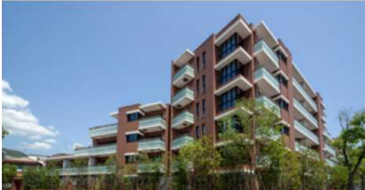
外観写真(2015年5月撮影)
