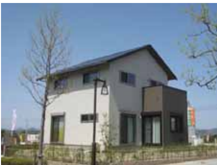
太陽光発電(5.544kW)、エネファーム
